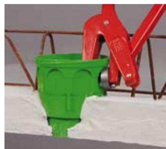
Das Rohr wird fest und passgenau eingeführt und die Dose mit dem Deckel verschlossen.
